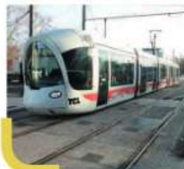
Chantier Lyon : un réseau de tram en pleine expansion
